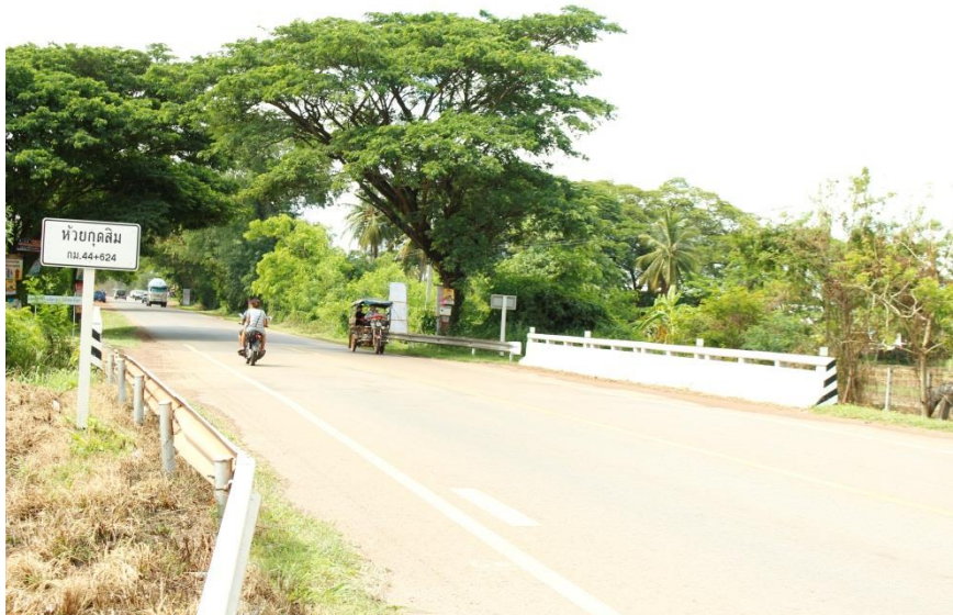
ภาพที่ 4.12 สะพานเชื่อมต่อกับคลองน้ำ “ห้วยกุดสิม” ในพื้นที่อำเภอบ้านดุง ที่มา: อำเภอบ้านดุง ถ่ายเมื่อวันที่ 6 มิถุนายน 2560
