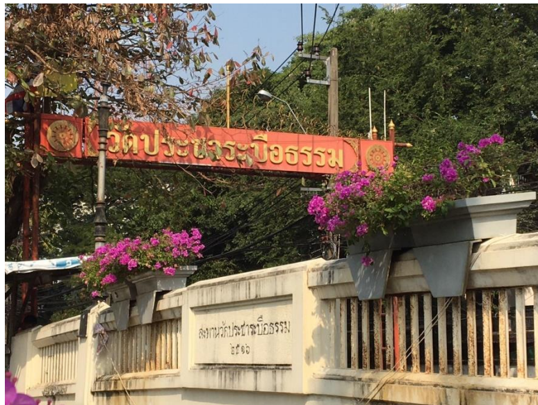
ภาพที่ 4.3 สะพานทางเข้าชุมชนวัดประหาระบือธรรม (ถ่ายเมื่อวันที่ 3 กุมภาพันธ์ พ.ศ. 2564)
