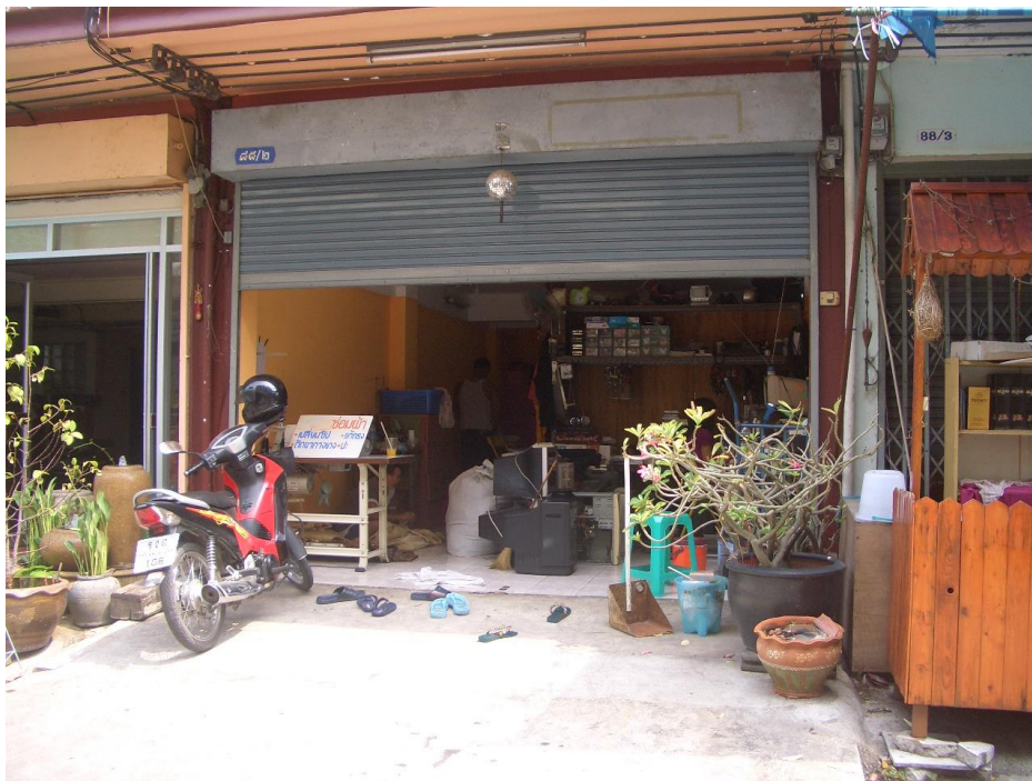
ภาพที่ 4.4 ลักษณะที่อยู่อาศัยแบบอาคารพาณิชย์ ประตูปแบบเหล็กม้วน แหล่งที่มา : ชุมชนวัดประหาระปือธรรม 4 (ถ่ายเมื่อวันที่ 5 เมษายน พ.ศ. 2552)
