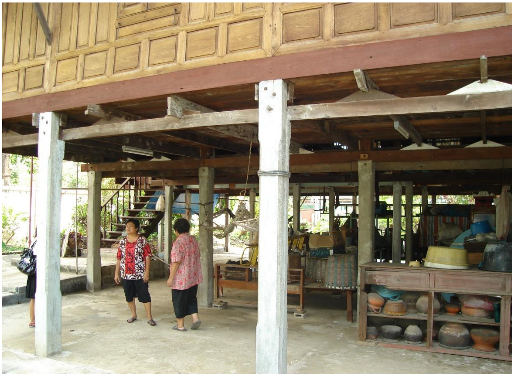
ภาพที่ 2.25 ลักษณะเป็นบ้านเรือนไม้ชั้นเดียวใต้ถุนสูง [ที่ปักอย่างเดิยว] เปลี่ยนจากเสาไม้เป็นปูน ที่มา: ชุมชนวัดประหาระบือธรรม 2 [ถ่ายเมื่อวันที่ 5 เมษายน พ.ศ. 2552]
