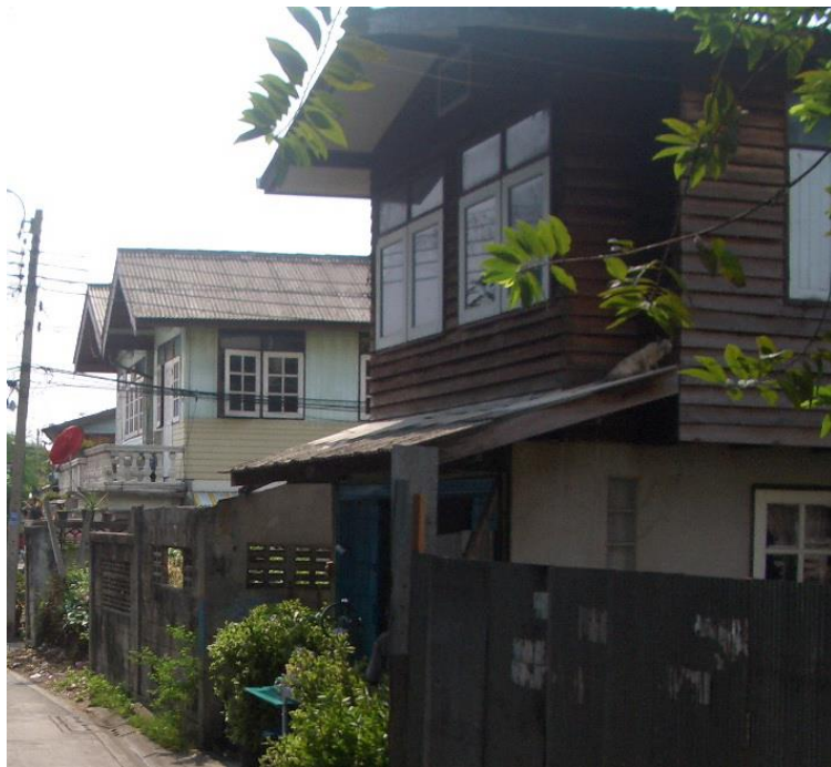
ภาพที่ 2.23 ลักษณะเป็นบ้านปูนและไม้ 2 ชั้น [ที่พักอาศัยอย่างเดียว] ที่มา: ชุมชนวัดประหาระบือธรรม 2 [ถ่ายเมื่อวันที่ 5 เมษายน พ.ศ. 2552]
