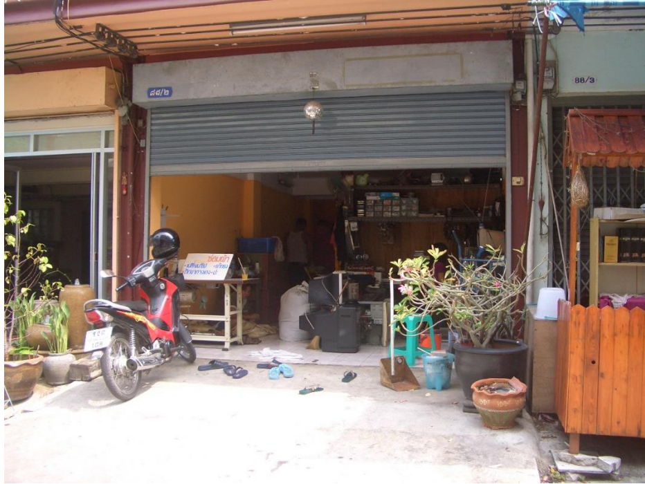
ภาพที่ 2.67 ลักษณะที่อยู่อาศัยแบบอาคารพาณิชย์ ประตูแบบเหล็กม้วน ที่มา: ชุมชนวัดประหาระบือธรรม 4 [ถ่ายเมื่อวันที่ 5 เมษายน พ.ศ. 2552]
